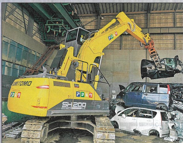
SH200LC-7EC：アマルク会津一ノ堰で稼働する住友建機（会津一ノ堰）
