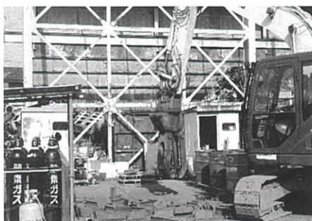
▲鋼材を機械で加工する様子
